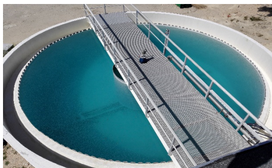
Melhoria da qualidade do tratamento da ETA de Vale da Pedra Beneficiário: EPAL-Empresa Portuguesa das Águas Livres, S.A.
